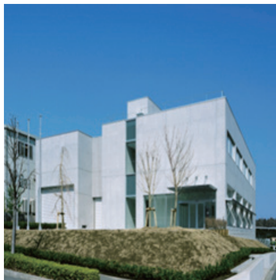
図 2. 商船三井技術研究所外観
