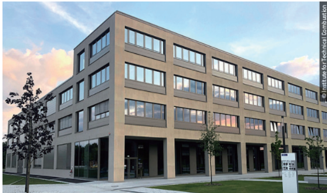
図 2-4 Garbsen キャンパスの研究棟「Dynamik der chemisch-thermischen Energiewandlung」 1)
