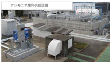
アンモニア燃料供給装置
