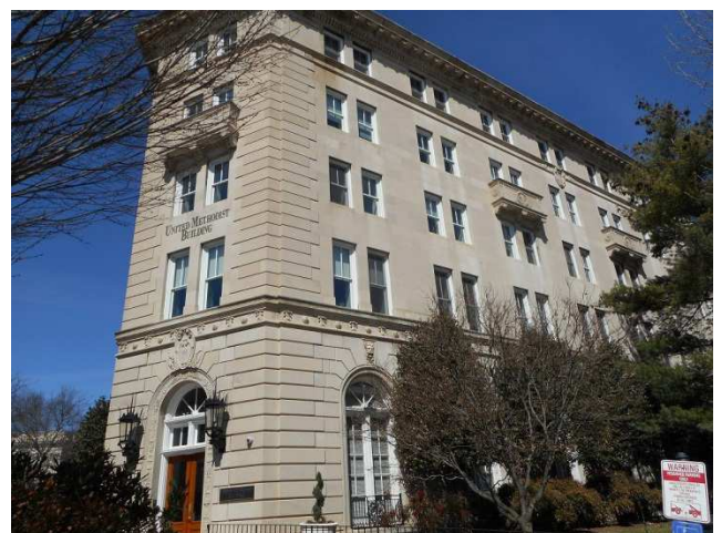
写真-2 2 日目の会場となった Methodist Building 外観
